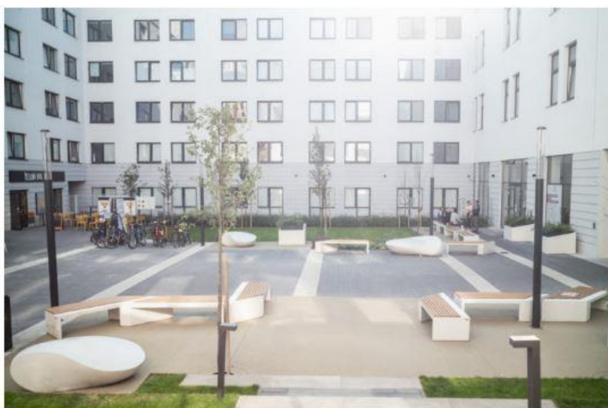
Az udvari rész padokkal, bringatárolókkal és dizájnkvacsokkal. Innen jól látszanak a régi épület (jobbra) 4 méteres nettó belmagasságú szintjei és az új részek nettó 2,7 méteres belmagasságú szintjei, illetve ezek különbsége. Egy lépcsőházat csináltak, a közlekedési mag hidalja át a rendszerek közötti különbséget.
